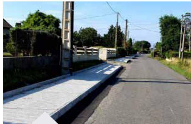
Fin de l'aménagement de l'avenue du Bouquier
