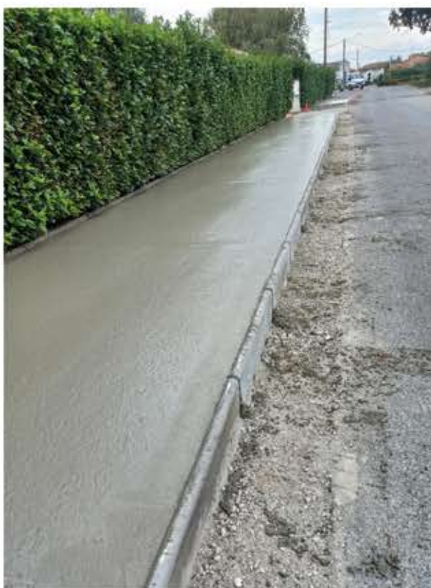
Continuité du piétonnier avenue du Bouquier, fin du chantier 1er semestre 2023
