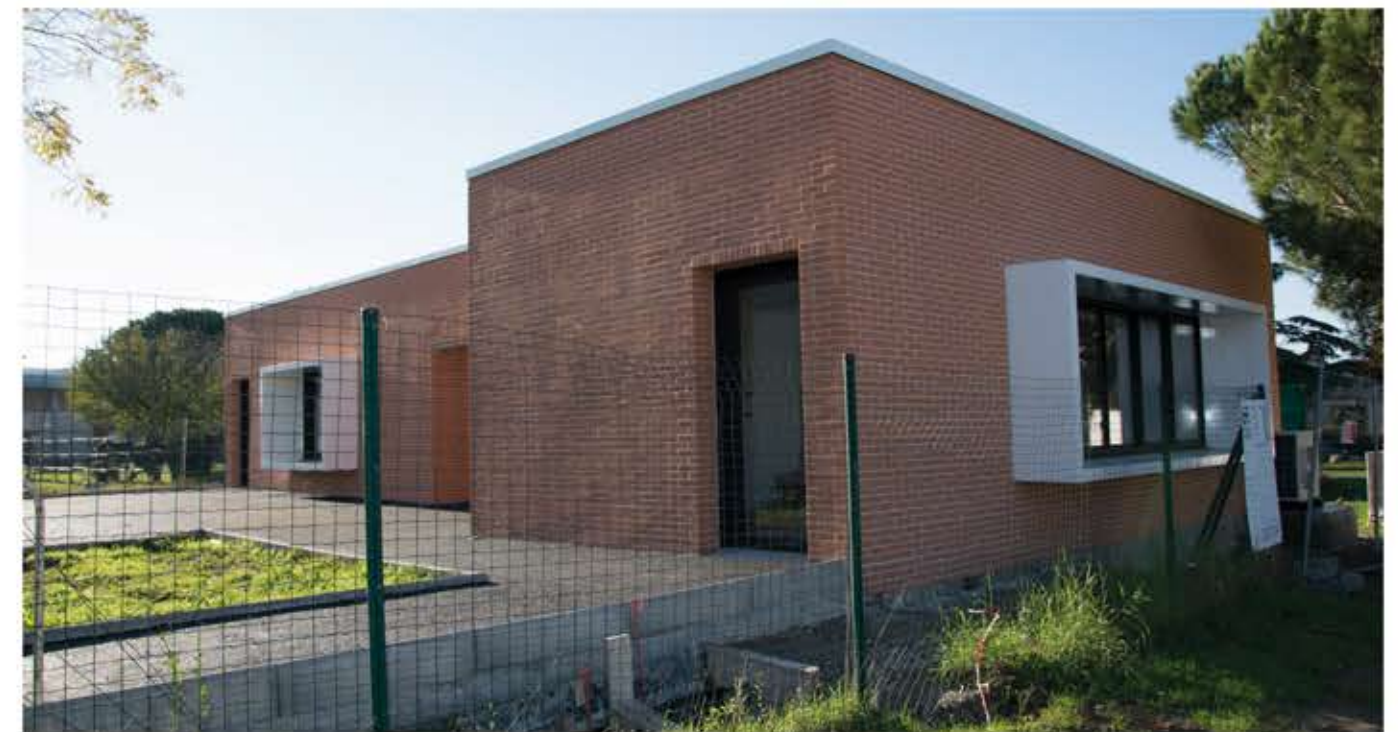
Le nouveau bâtiment de l'école maternelle est bientôt terminé
