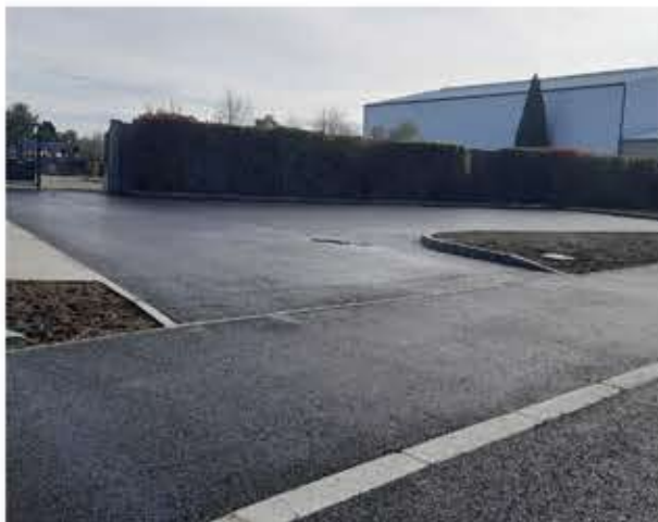
Urbanisation du chemin des Berges, durée du chantier 3 ans
