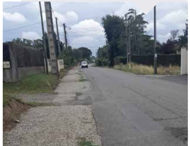
Création en cours d'un piétonnier avenue du Bouquier
