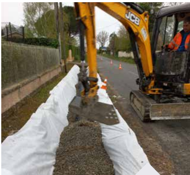
Création en cours d'un piétonnier avenue du Bouquier
